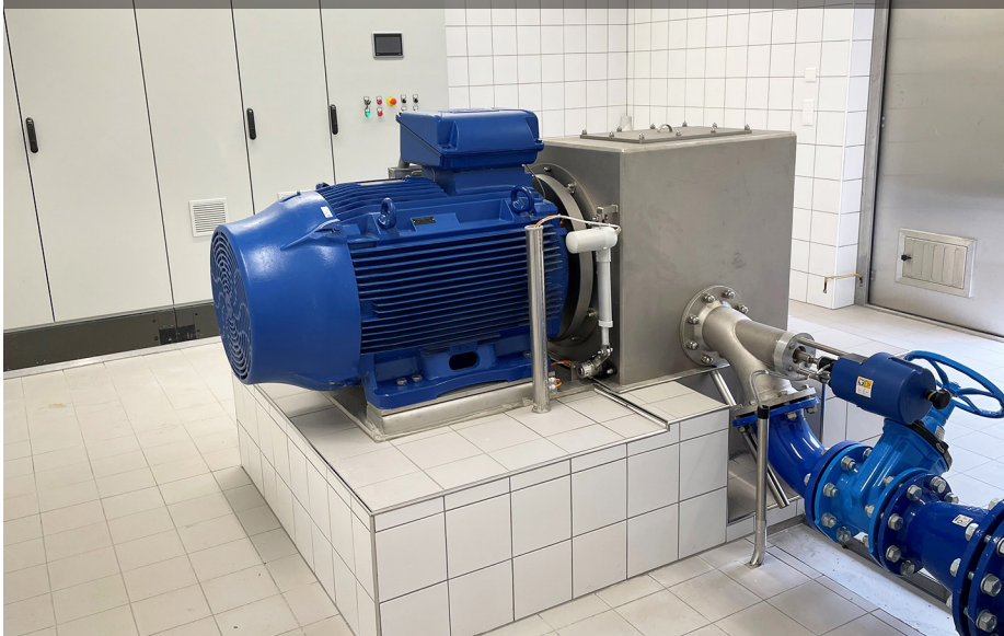
Der hydraulische Öldruckregler des Bräukraftwerks wurde im Zuge der Modernisierung ebenfalls automatisiert.
