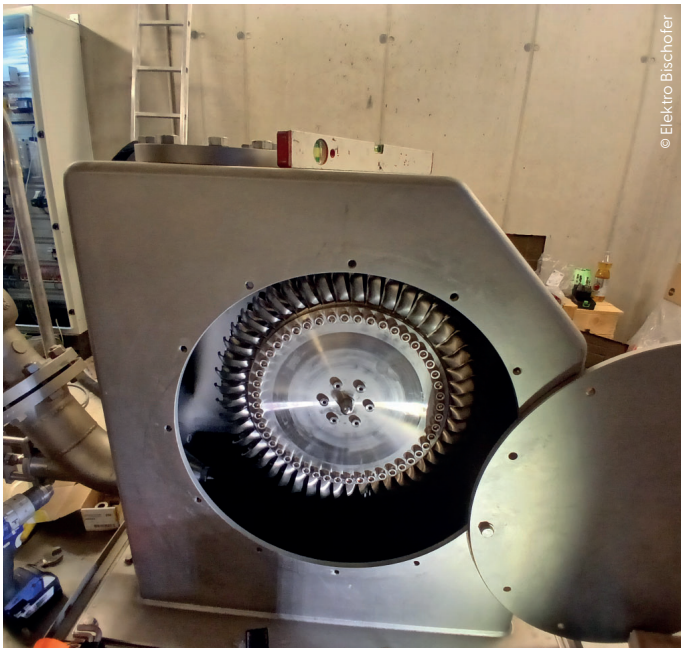
Trinkwasserkraftwerk Seitenwandquelle in Bach im Lechtal: Ausbauleistung: 17 kW Fallhöhe: 308 m Ausbauwassermenge: 7 l/s Turbine: 1-düsige Pelton-turbine Inbetriebnahmen: 2025 Betrieb: Netzparallel- & Inselbetrieb
